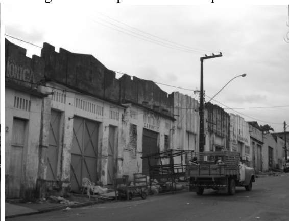
Figura 6 - Galpões na rua Duque de Caxias
