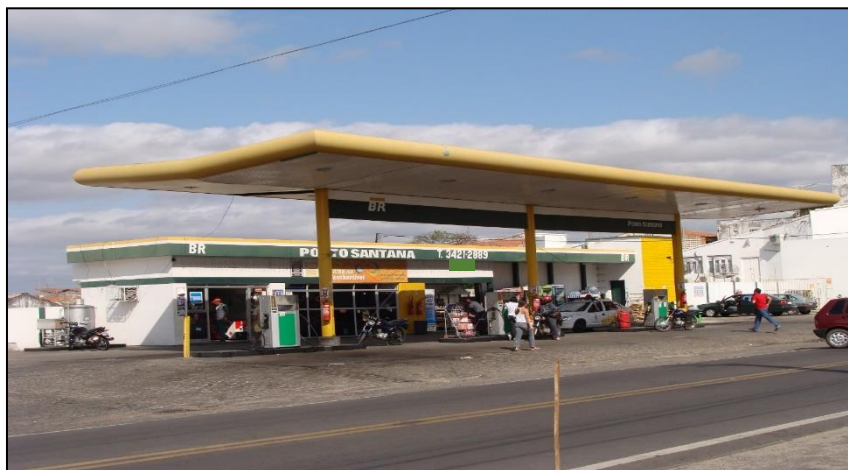
Fotografia 3 Caicó – Posto de combustíveis na BR 427
