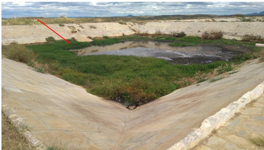
Imagem 1. Serviços de impermeabilização no fundo das lagoas anaeróbicas inacabados.
