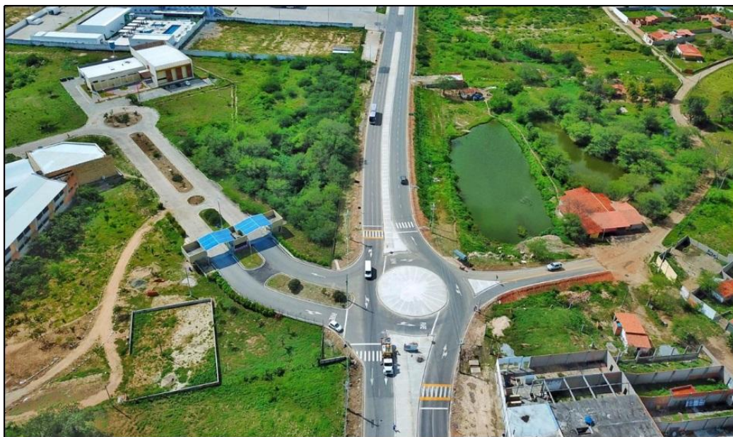
Figura 1: Duplicação da AL 145 e rotatória da entrada do campus da UFAL em Delmiro Gouveia
