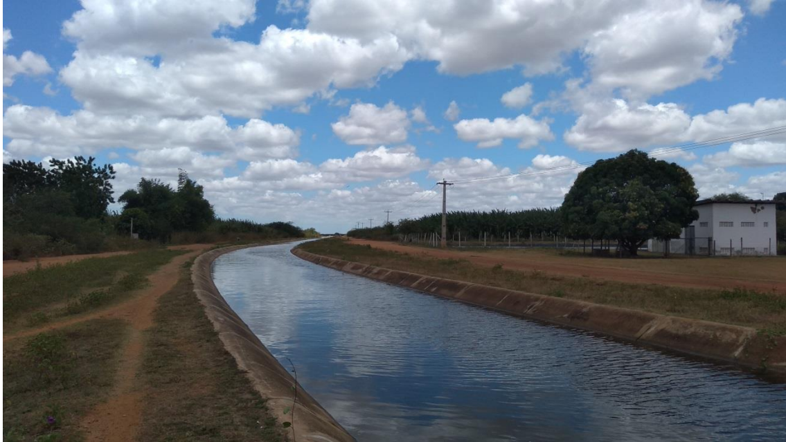
Foto 1: Canal Principal de Irrigação do Distrito de Irrigação do Baixo Açu - DIBA
