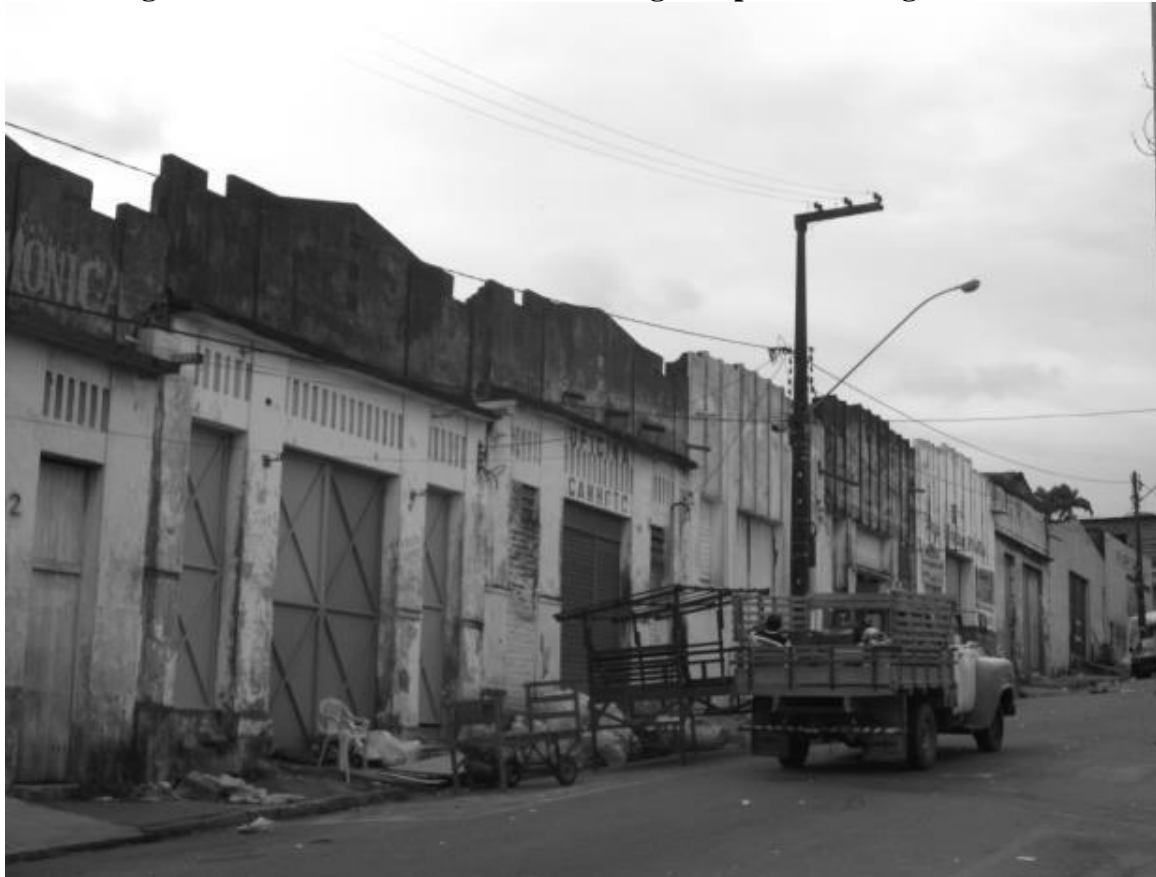
Figura 08 - Oficinas mecânicas nos antigos depósitos de algodão/sisal.
