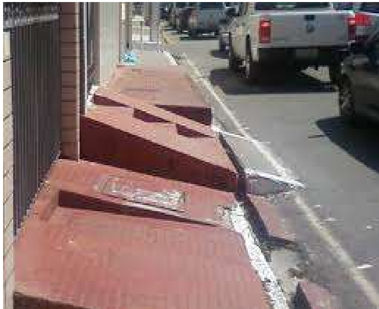
Foto 02 – Calçadas construídas fora do padrão recomendado pelas normas da ABNT obstaculizando a circulação da pessoa com deficiência em Ponta Grossa-PR.
