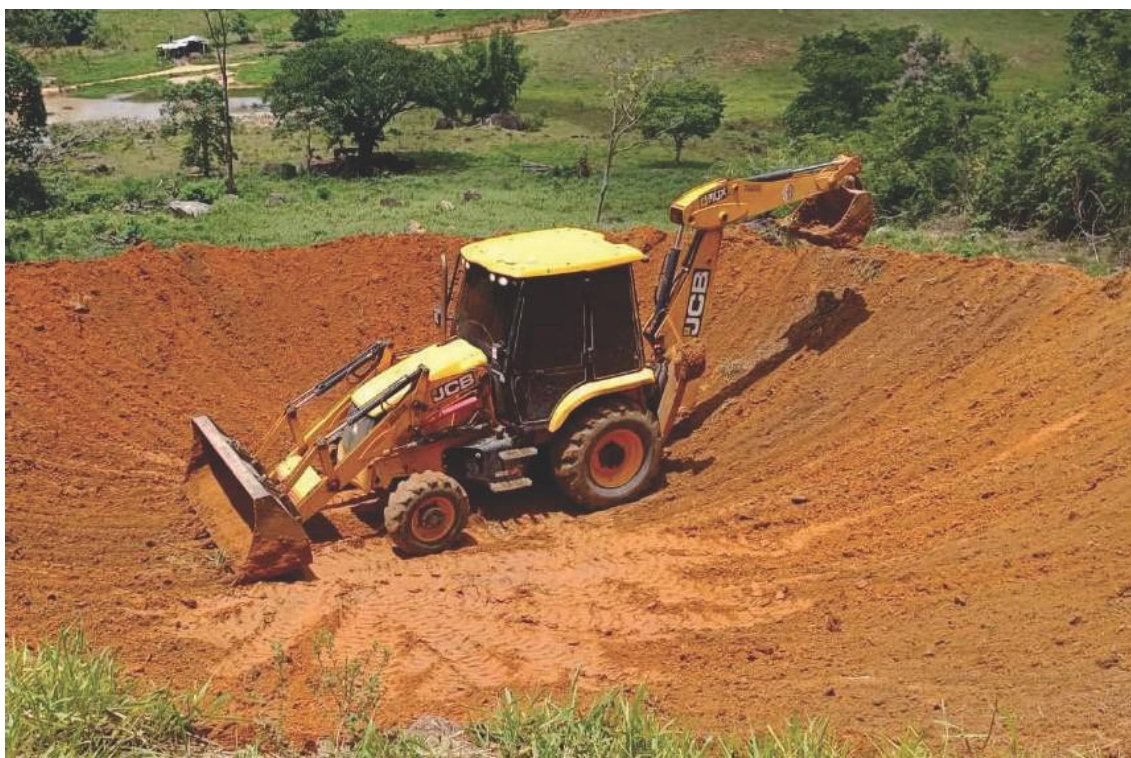
Figura 5. Início das obras de uma Barraginha no município de Águia Branca, estado do Espírito Santo (sudeste do Brasil). Fonte: PMAB (2023) .
